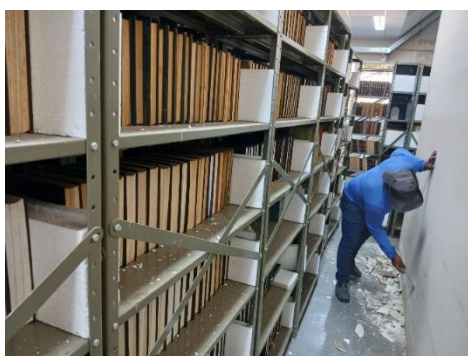
Reparos em diferentes espaços
