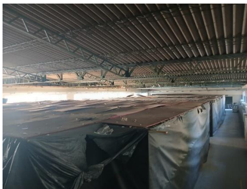
Foto do telhado e acervo acondicionado
